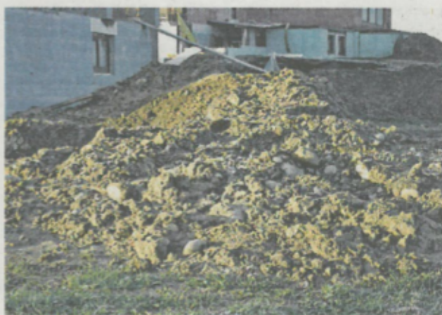
Riečne kamene a hlina odkryté pri radovej výstavbe v Oravskom Podzámku.
